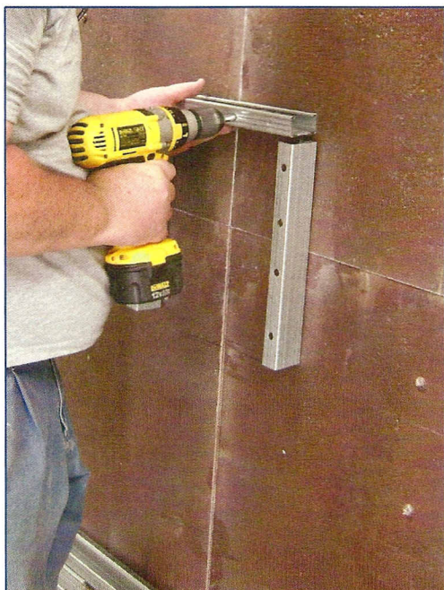
Giunzione con viti autofilettanti
