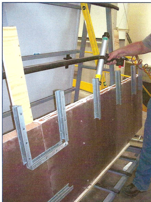
Ulteriori canalini per realizzare la giunzione e posa dell'adesivo poliuretano
